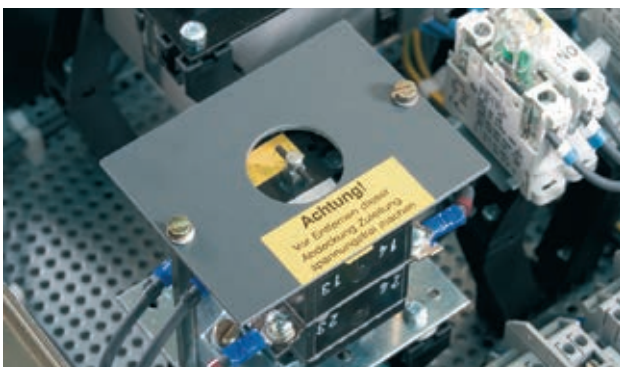
Bild 8: Berührungsschutz
