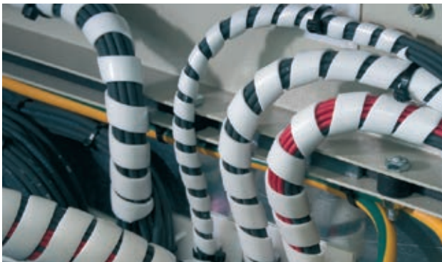
Bild 7: Getrennte Bündelung von Leitern
