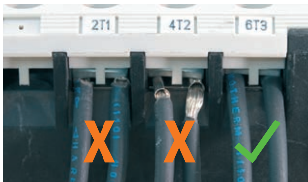
Bild 6: Richtiges und falsches Auflegen der Leitungen
