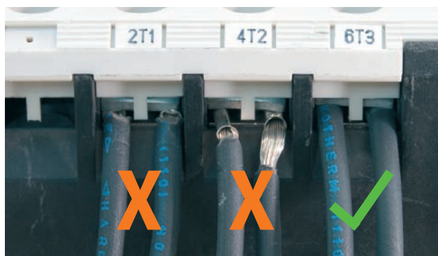
Bild 6: Richtiges und falsches Auflegen der Leitungen
