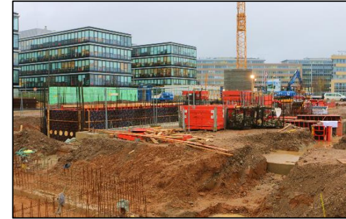
Startschuss für den Bau des neuen Produktions- und Entwicklungscenters in Köln
